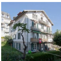
Rue de la Pontaise 15 1018 Lausanne
