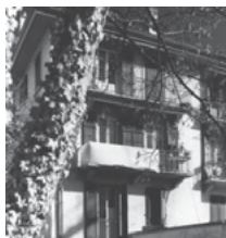
Avenue des Figueiers 41, 43 1007 Lausanne
